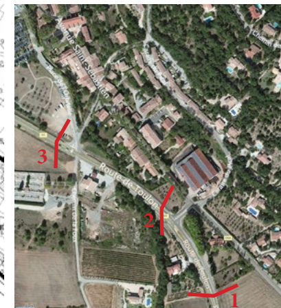
Vue aérienne de l'entrée Sud
