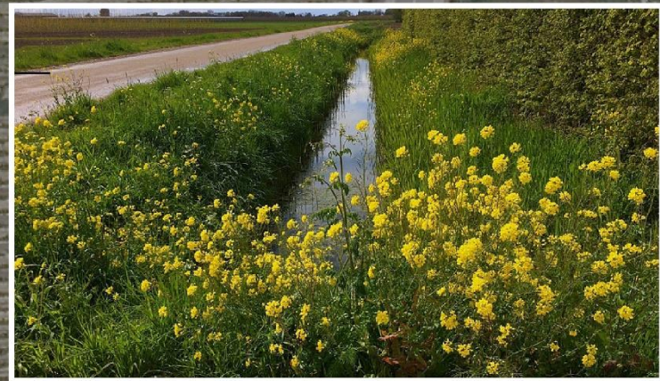
Réseau de noues paysagères, participant à la gestion des eaux pluviales
