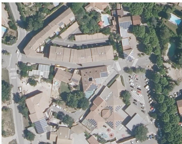
Bâtiments publics équipés (mairie, médiathèque...)
