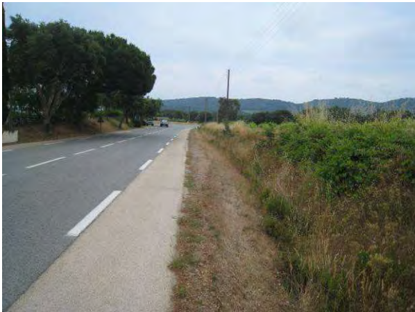
fossé pluvial le long de la RD 93 (aval)
