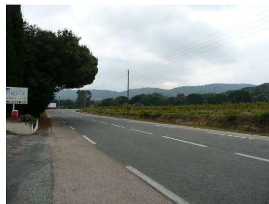
RD93 au droit du site des Combes-Jauffret
