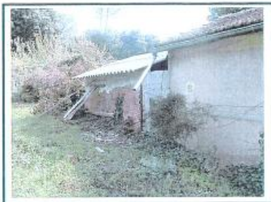
Vues 6 et 7 : désordres observés dans une habitation proche de l'ancienne plâtrière et où le gypse est sous-jacent
