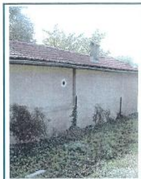
Vues 6 et 7 : désordres observés dans une habitation proche de l'ancienne plâtrière et où le gypse est sous-jacent
