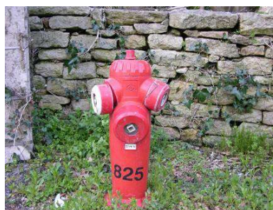
Exemples de numérotation de poteaux incendie
