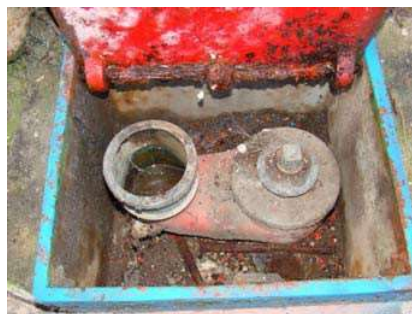
Bouche Incendie de 80 mm à raccord Keyser
