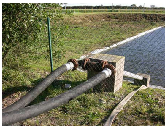
Deux sorties de 100 mm sur une colonne de 150 mm
