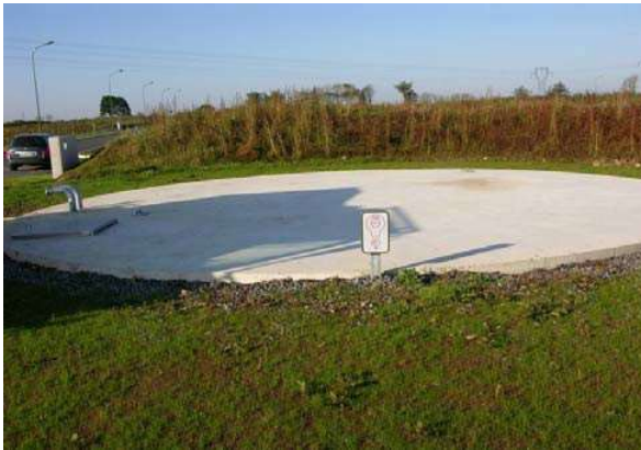
Rserve d'eau enterrée
