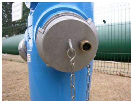
Poteau d'aspiration de 150 mm muni d'un Airclap
