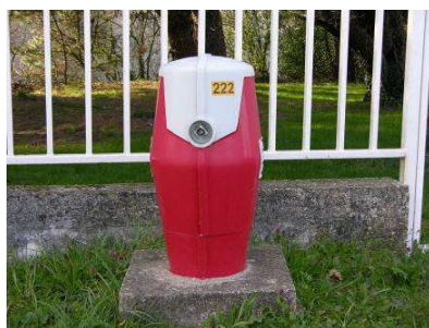
Exemples de numérotation de poteaux incendie
