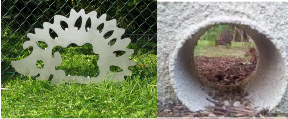
Figure 5 - Exemples d'ouvertures dans un grillage et un muret prévues pour le passage de la petite faune (Source : U2B - Limiter l'impact des clôtures sur la biodiversité, 2014)
