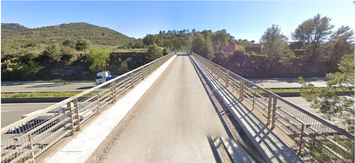
Figure 2 : ponts et tunnels pour passer l'autoroute A8 (source : Google streetview)
