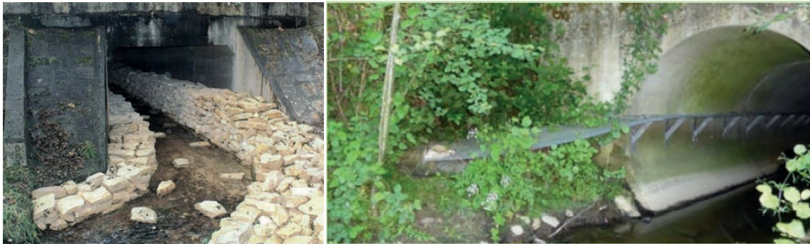
Figure 4 : Exemple de banquette en matériaux naturels et banquette plastique (Source : Les passages à faune, Cerema )
