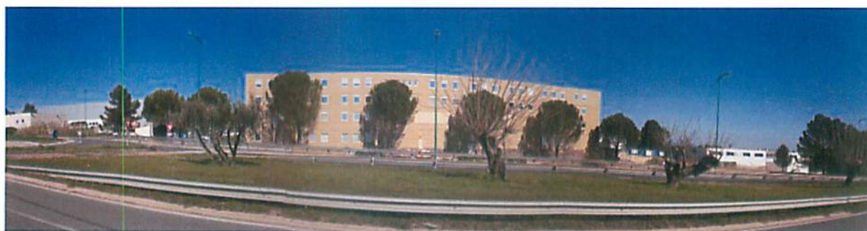
Vue du 1er plan de la zone des ferrières, le long de la RD1555
