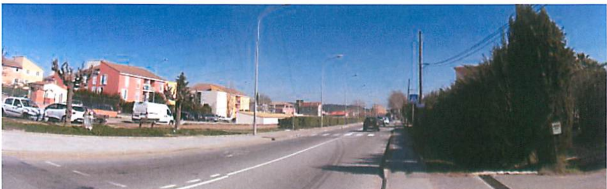
La RDN7, une entrée de ville, en attente de requalification
