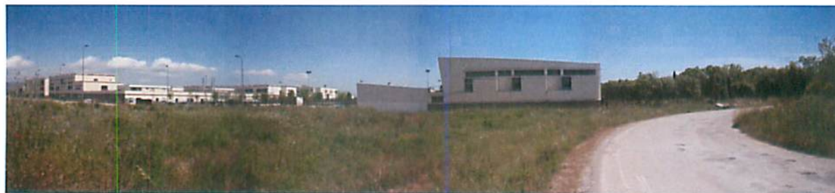
Le lycée du Val d'Argens avec, en premier plan, la parcelle libre
