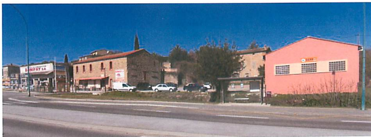
Le boulevard de la Libération, en attente de renouvellement urbain
