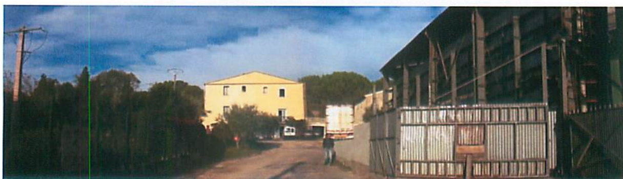
La façade arrière de la zone, une atmosphère plus hétérogène
