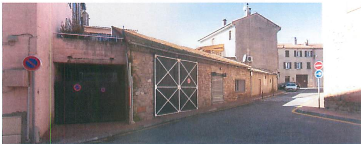
Un potentiel de densification : les garages, dépôts ou activités économiques en rez de chaussée
