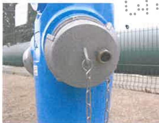
Poteau d'aspiration de 150 mm muni d'un Airclap
