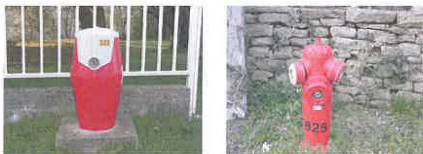
Exemples de numérotation de poteaux incendie
