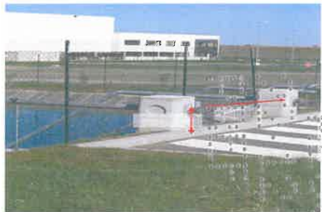
Plate forme d'aspiration sur une réserve d'eau équipée de deux colonnes d'aspiration de 100 mm
