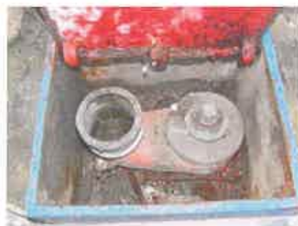
Bouche Incendie de 80 mm à raccord Keyser
