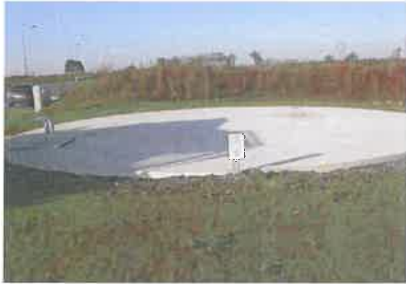
Réserve d'eau enterrée
