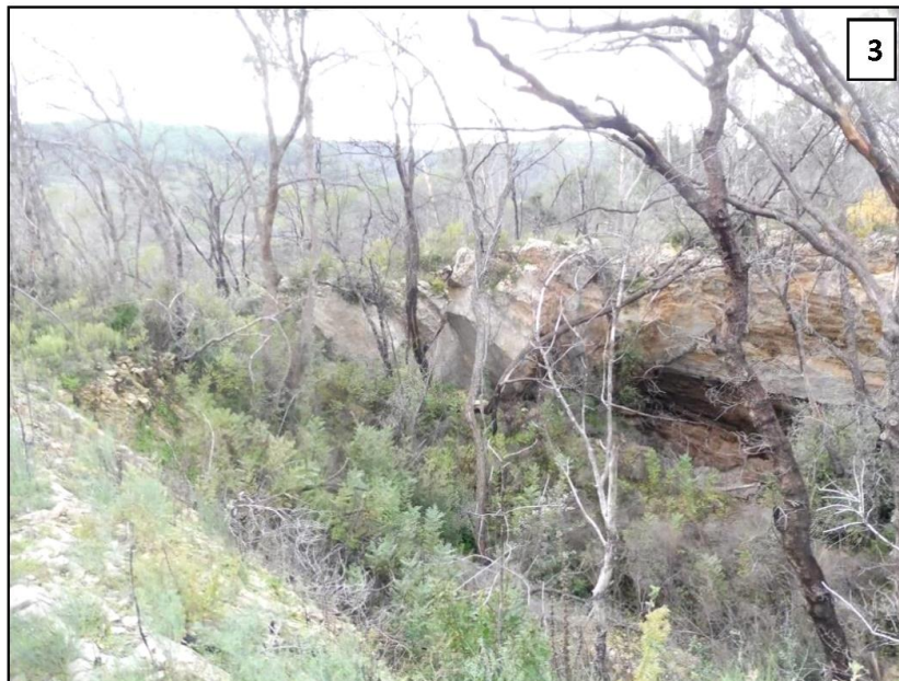
Figure 8. Effondrement ancien dit de la Baume
