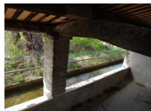
Intérieur du lavoir de la parcelle 25 (réhabilité)
