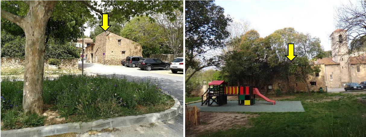
Vues sur les remises depuis le parking et le jardin public.
