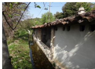
Vue des lavoirs depuis le canal
