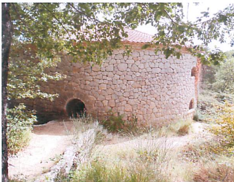
Aperçu de la glacière de Pivaut après réhabilitation
