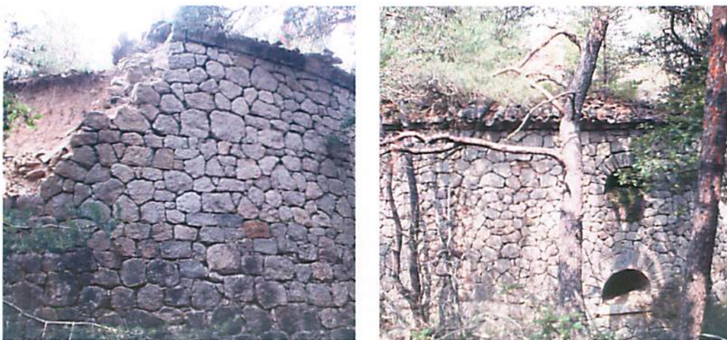
Aperçu de la glacière de Pivaut avant réhabilitation
