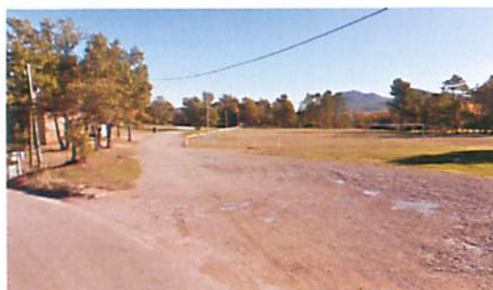
Aperçu de la voie d'accès à la station d'épuration
