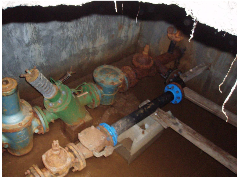
Figure 7 : Photos de la chambre de vannes du stade
