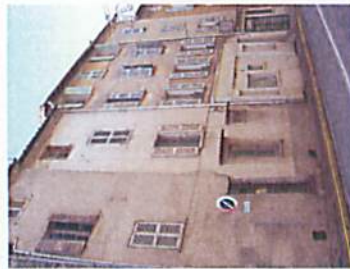
Réhabilitation du patrimoine bâti
