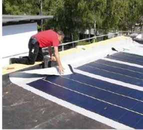
Membrane souple – Toit Terrasse
