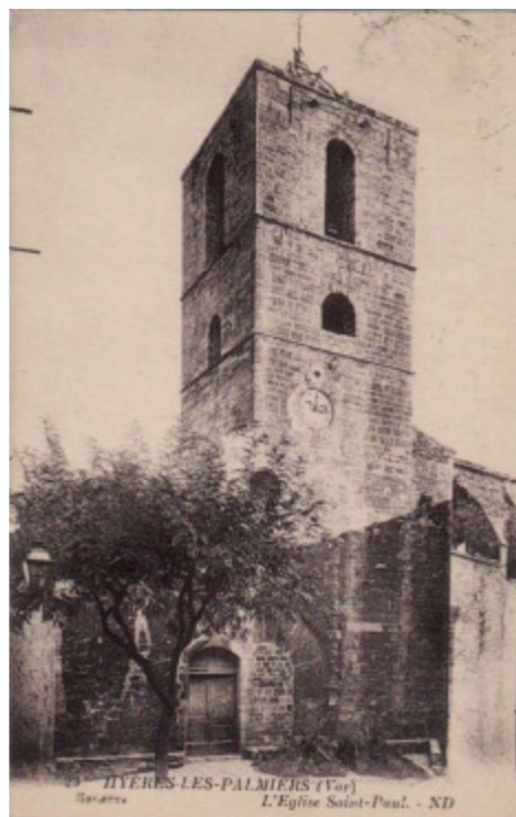
Église Saint-Paul Façade Ouest avant restauration de la porte
