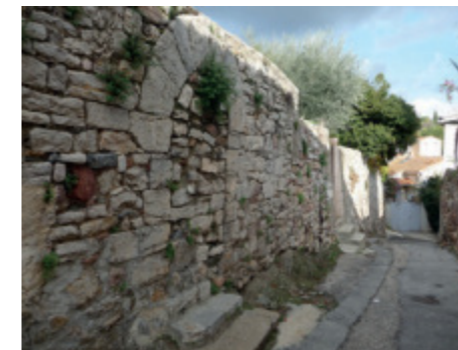
Mur de clôture provenant de démolition
