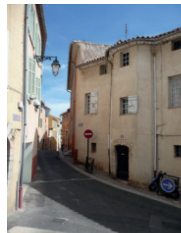
Tour d'escalier hors œuvre r. P. Émile
