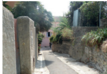
Mur de moellons enduit
