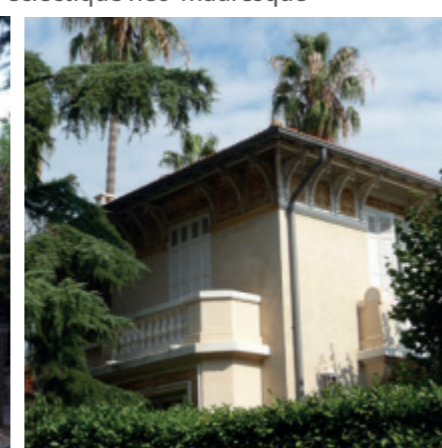
Débord de toiture sur aisseliers et frise
