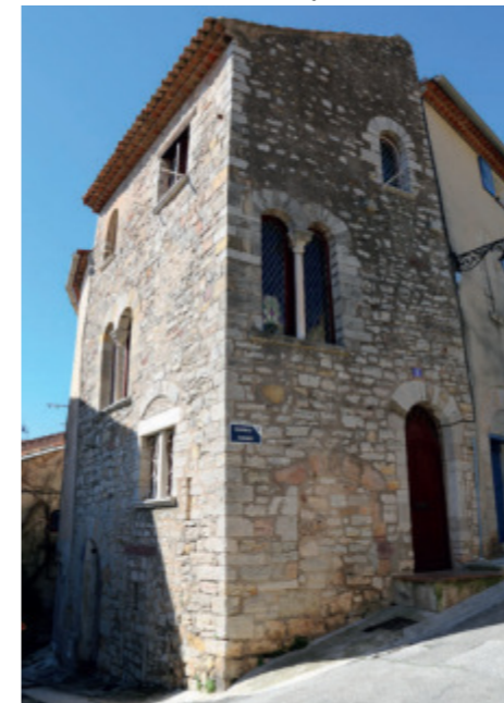
Maison romane (façades classées MH 26/09/1926)
