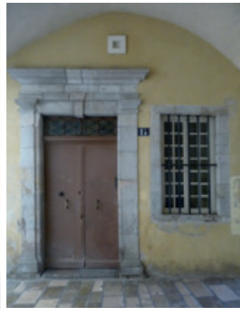
Portail XVII° avec chapiteaux toscans en référence à l'architecture de la Renaissance. Baie rectangulaire avec menuiserie d'origine à petits carreaux. Grille en feronnerie.
