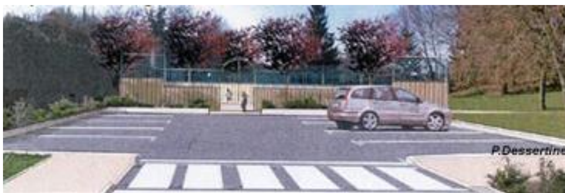
Aménagement d'espace de stationnement en petits blocs, au sein de l'espace public.
