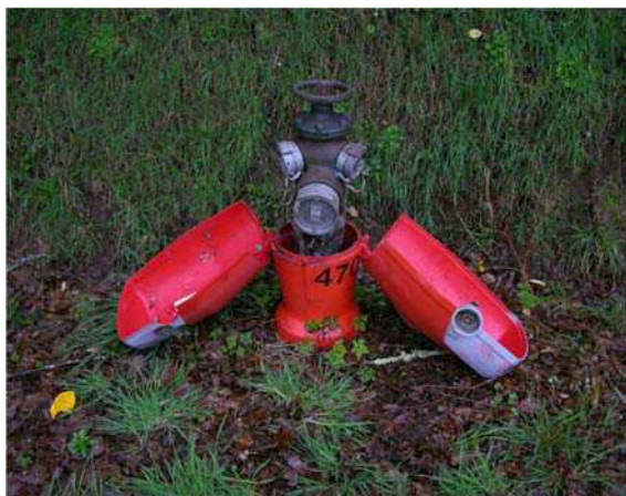
Poteau Incendie de 100 mm avec une sortie de 100 mm et deux sorties de 65 mm
