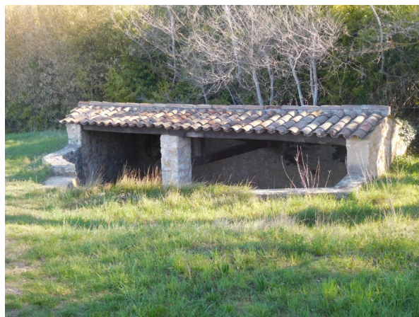
101. Lavoir, Bastide de Bouche, D 832 (contre la RD 60)
