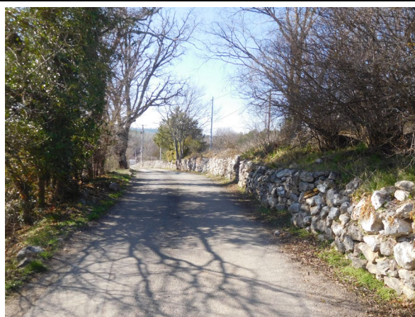
115. Muret en pierres sèches, le long des parcelles D 1514, 1453 et 1328, Amphoux
