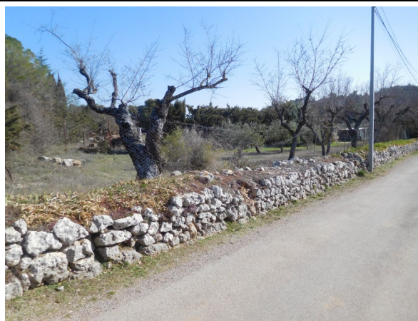
113. Muret en pierres sèches, le long de la parcelles D 1085, Amphoux
