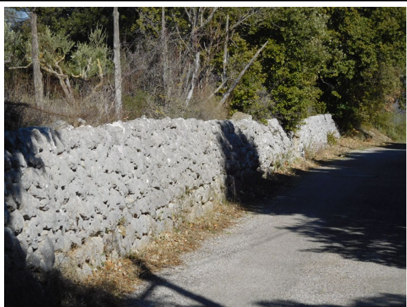
114. Muret en pierres sèches, le long des parcelles D 52 et 53, Amphoux
