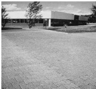
Parking réservoir et pavés drainants de la zone d'activité du Phare (33) Source CETE du Sud-Ouest
