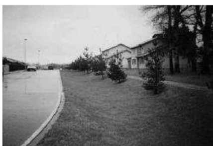
Noue le long d'une voirie desservant un habitat aéré Source CETE du Sud-Ouest
