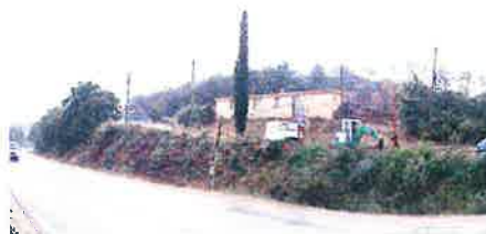
Photo n°25 La ZA côté Nord en provenance du village
