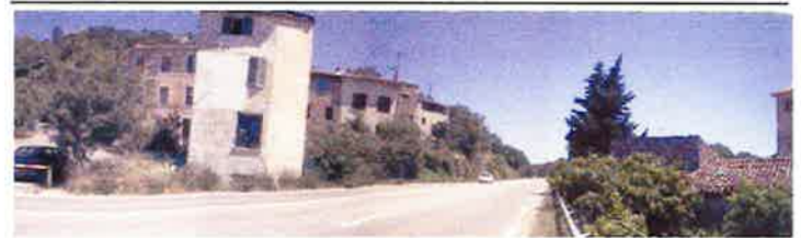
Photo n°1: Passage de la RN7 au niveau de la partie supérieure du hameau oriental
