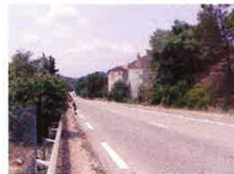
Photo n°2: Mur pignon du hameau oriental (partie haute) donnant sur la RN7
