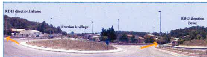
Photo n°18 Giratoire à l'intersection de la RD13 avec la RN7
