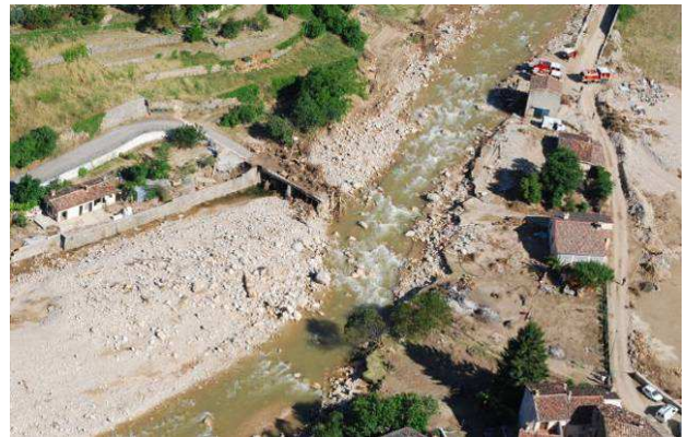
Photos 69 : La Nartuby à Rebouillon – Post Crue
