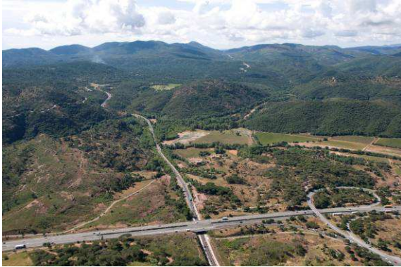
Photos 16 : L'Argens et les Déguiers en amont immédiat de la RD125-photo Post Crue
