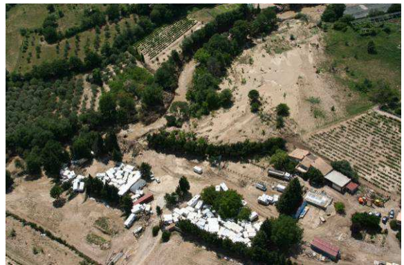
Photos 130 : Le Muy amont CD25 – secteur Serres Plaines Point de débordement rive gauche – Vue post crue
