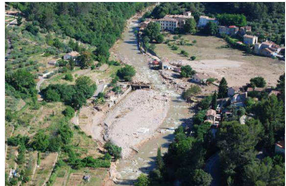
Photos 67 : La Nartuby à Rebouillon – Post Crue
