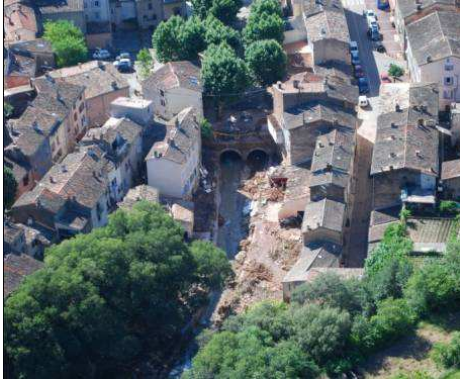
Photos 44 : Le Réal dans le centre ville des Arcs – Détail du passage souterrain – Vue amont post crue
