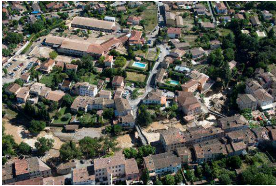
Photos 111 : Trans en Provence centre – Post Crue
