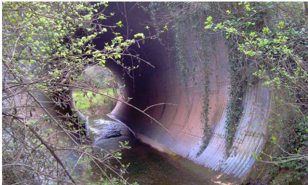
Photos 18 : L'ouvrage de la décharge du Vallon des Déguiers sous la RD125
