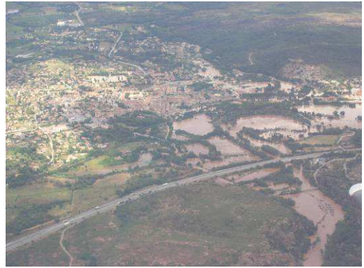
Photos 135 : Le Muy – La Nartuby en amont de la confluence avec l'Argens – Le 16 juin (décrue)
