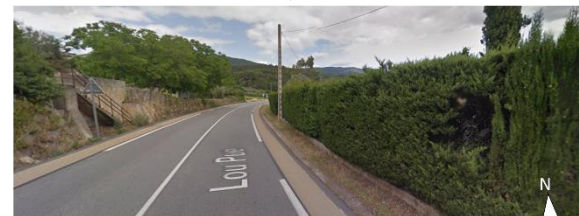
Vue 9 : vue depuis la RD54 en direction de Montferrat
