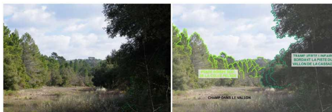
Vue 8 depuis le champ en fond de vallon après le passage de la ligne électrique (et sa vue interprétée)
