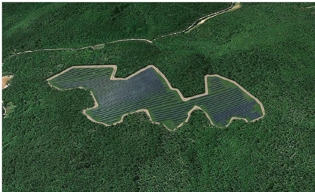
VUE AERENNE PROJETEE DEPUIS LE NORD
