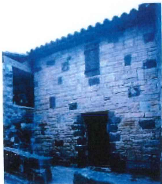
3-Rénovation avec un matériau rapporté.
