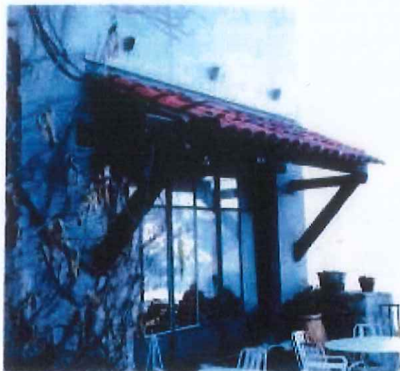
ossature bois et couverture de tuile ronde
