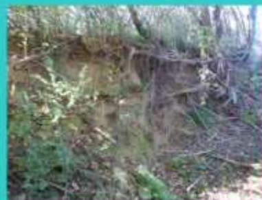
Berge érodée et boisement instable (pk 19.5)
