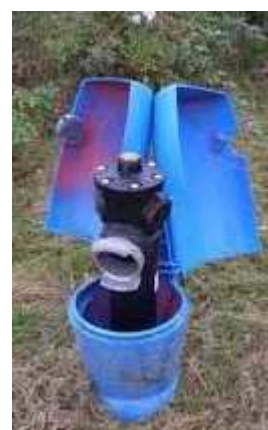
Poteaux d'aspiration de 100 mm à réseau sec, munis d'une seule sortie de 100 mm. Pas de volant ni de carré de manœuvre.
