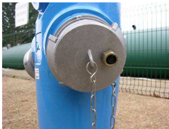
Poteau d'aspiration de 150 mm muni d'un Airclap
