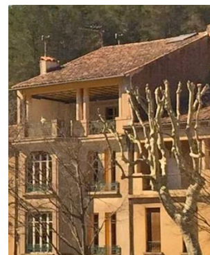
Exemple au nu de la façade
