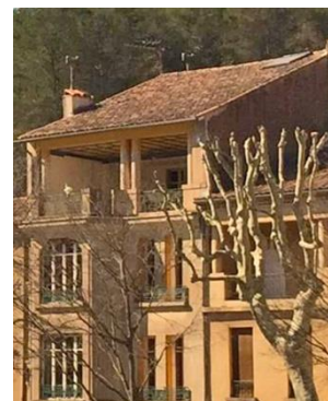
Exemple au nu de la façade
