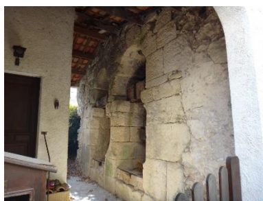
Mur du Moulin face intérieure
