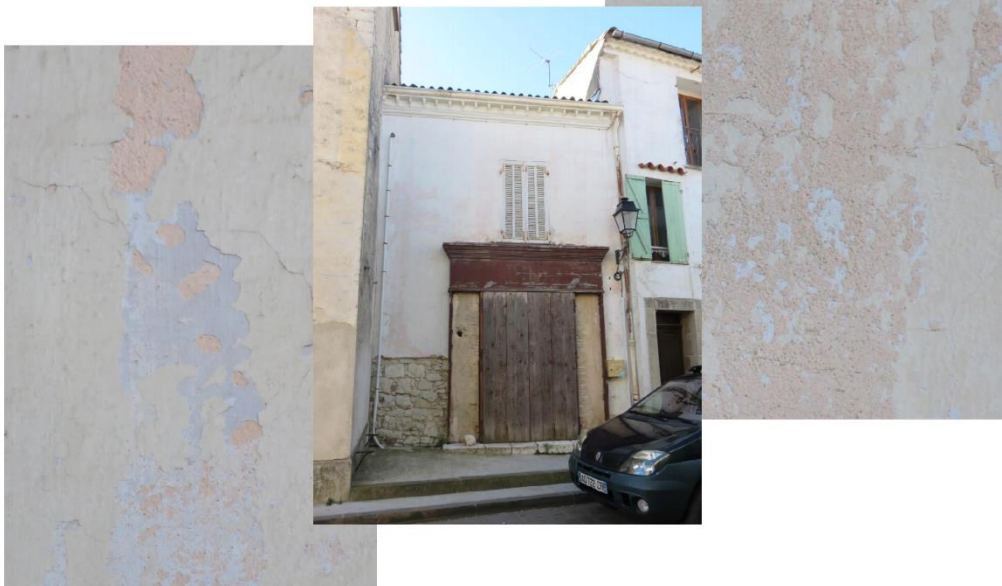
Rue de la Bourgade, sous la peinture organique qui s'écaille apparaît des traces de badigeon par strates, bleu et rose.
