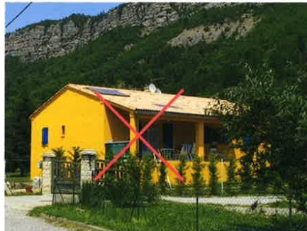
Enduit de teinte trop soutenue (à proscrire)
