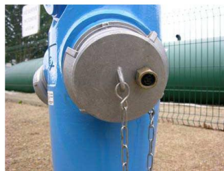
Poteau d'aspiration de 150 mm muni d'un Airclap
