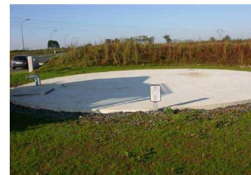
Réserve d'eau enterrée
