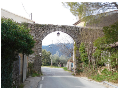
Aqueduc au village, surplombant la RD 51
