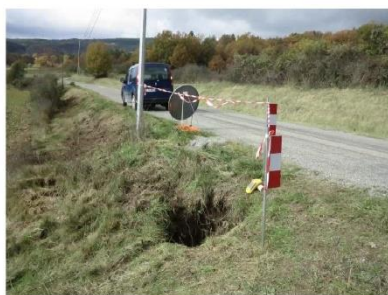
Effondrement localisé © GEODERIS
