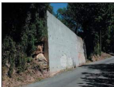
Mur de consolidation contre les glissements sur le chemin du Vieux Cannet
