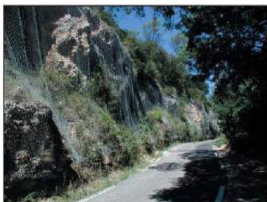
Filets de protection pour prévenir des chutes de blocs (Nord-Est de la commune)
