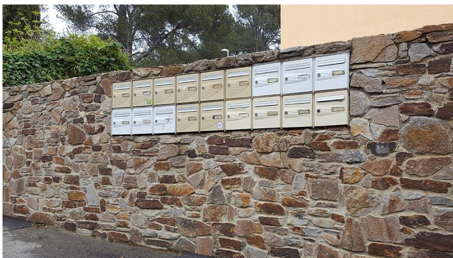
Exemple d'intégration des boîtes aux lettres dans un mur
