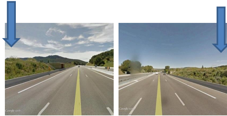
Vues depuis l'autoroute
