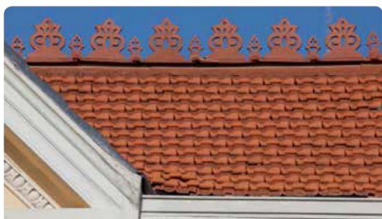
Chéneau en zinc Lambrequin de rive en zinc Lambrequin d'égout en zinc
