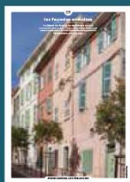
01 les façades enduites
