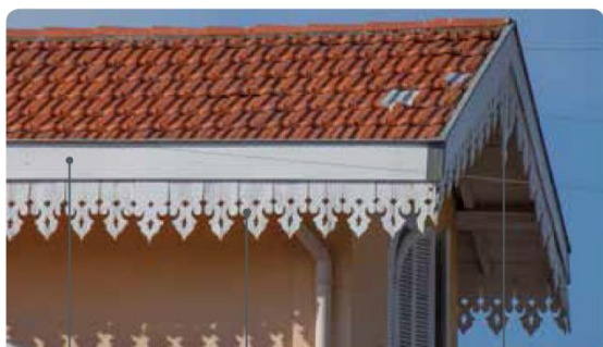
Chéneau en zinc Lambrequin de rive en zinc Lambrequin d'égout en zinc
