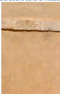
Exemple d'enduit frottassé.
