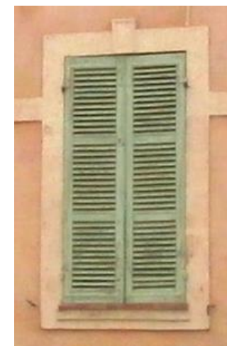
Exemple à suivre de contrevent à claire-voie.
