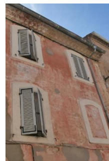
Exemple de fausse fenêtre.
