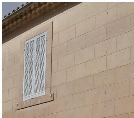
Les badigeons de chaux seront privilégiés au détriment des colorations dans la masse.
