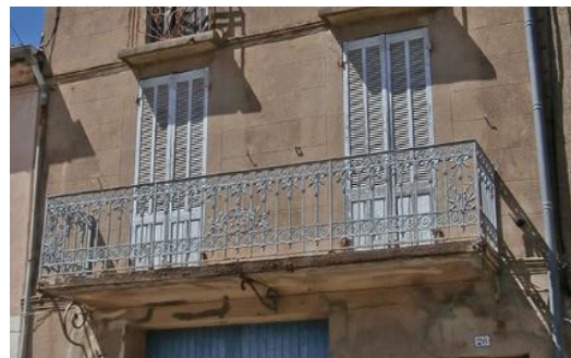
Exemples à suivre pour les balcons.
