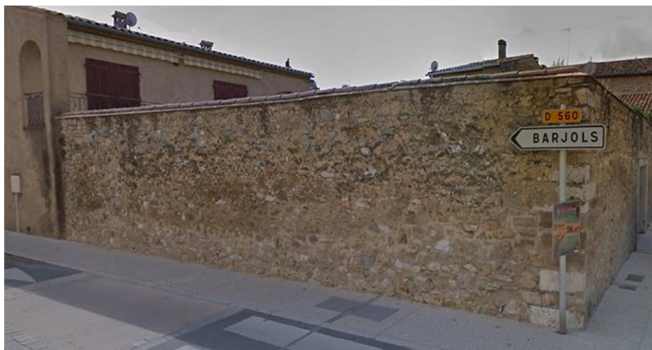
Mur d'angle en pierre, exemple à suivre.
