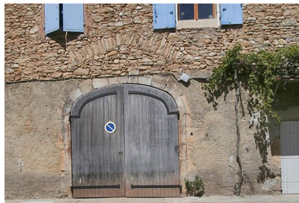
Exemple à suivre de linteau appareillé en pierre et arc de décharge.
