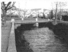
Vue amont du pont des Allées
