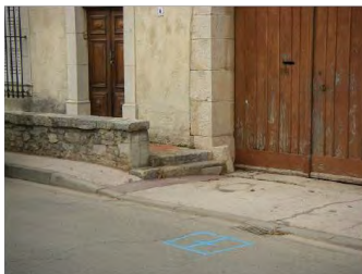
Fuite secteur 5 située 6 Avenue de la libération.
