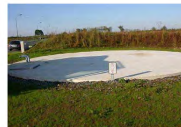
Réserve d'eau enterrée
