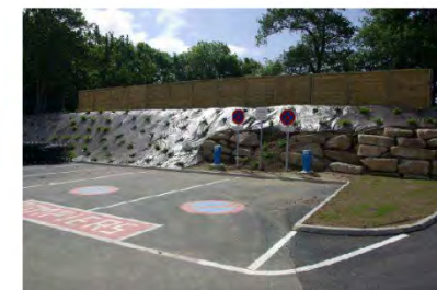
2 Plates formes d'aspiration sur une réserve d'eau équipée de deux poteaux d'aspiration de 150 mm
