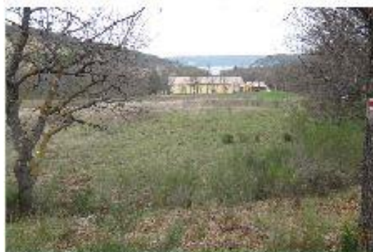
3- Vue sur le bâtiment au Nord de la zone situé en contre bas
