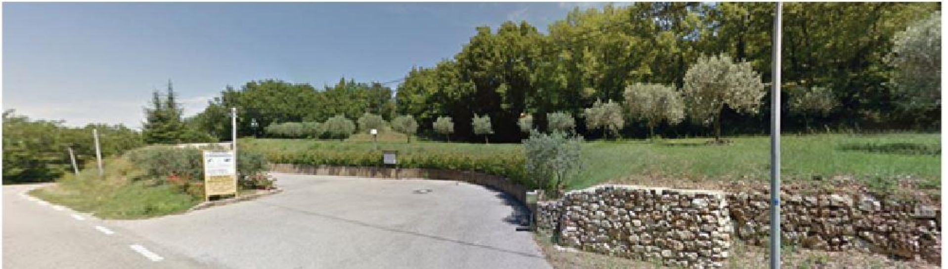
Perception de l'entrée du Camping « les Restanques » depuis la RD49 avant l'extension
