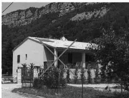
Enduit de teinte trop soutenue (à proscrire)
