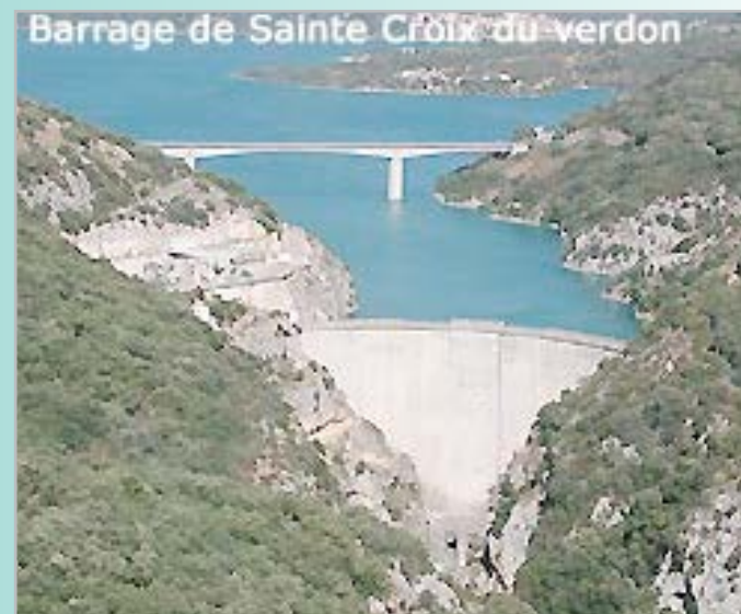
Barrage de Sainte Croix
