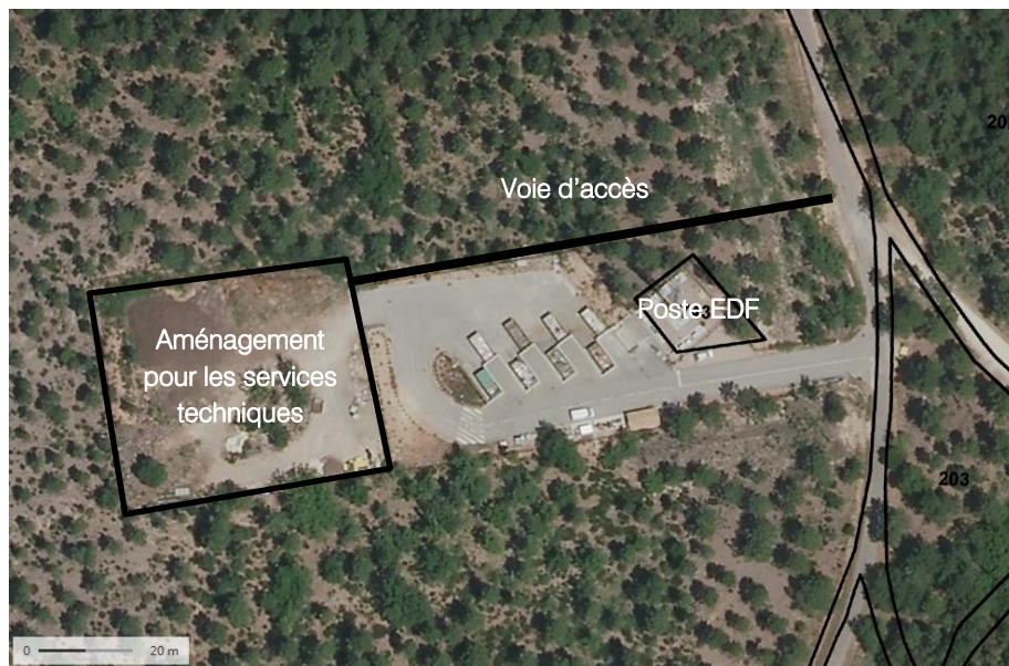
Photo aérienne du site de projet
