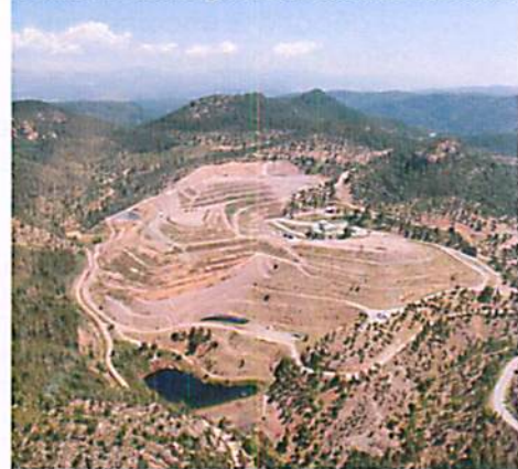
Centre de stockage des déchets des Lauriers
