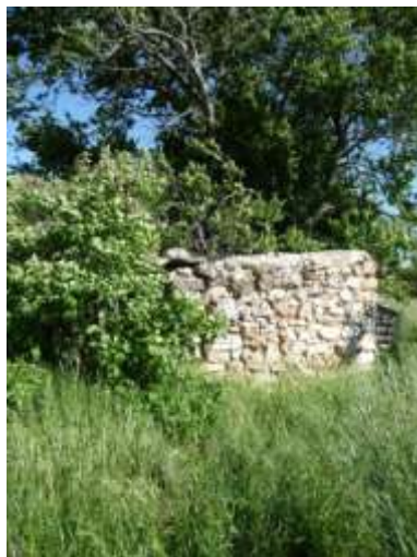
Petit bâti présent au sein d'une haie présente en bordure de prairies de fauche. Cet ensemble est très favorable à la présence des Chiroptères
