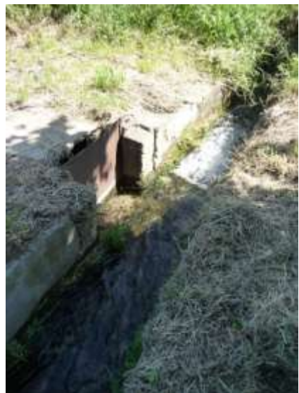
Canal d'irrigation à gestion manuelle permettant d'irriguer de manière différentielle les parcelles
