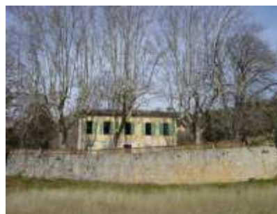
Sous la Feuillée
