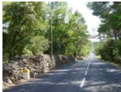
Murs en pierre sèche
