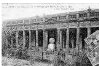
La fabrique autrefois à l'arrière de la bastide, aujourd'hui en très mauvais état
