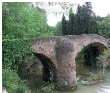
PONT DU GOURGARET
