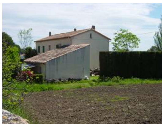
Le secteur des jardins en contre bas du centre ancien
