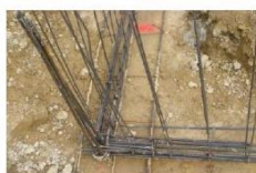
Nœud de chaînage - Continuité mécanique
