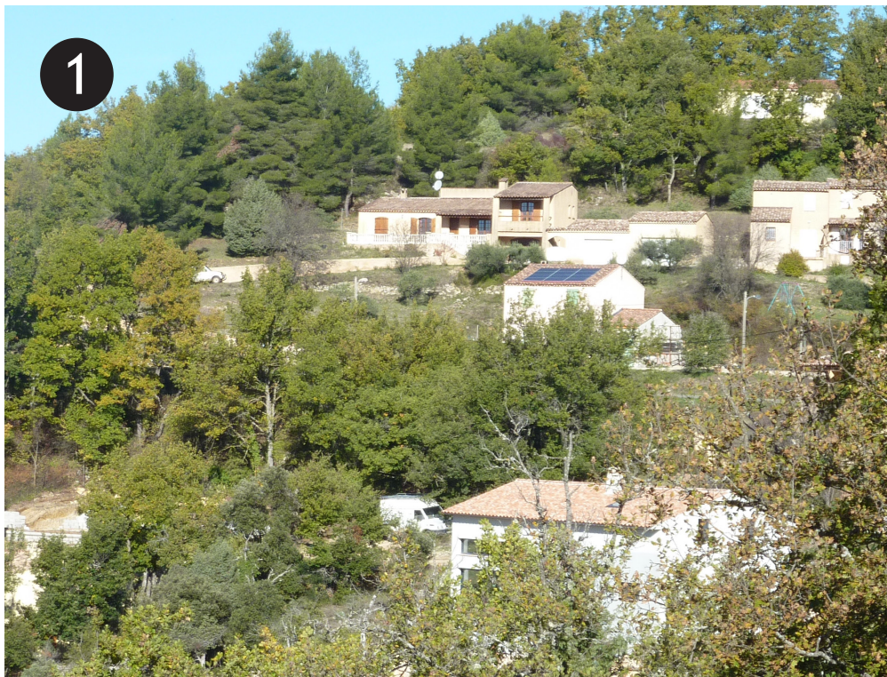
Pavillons existants dans la zone UD en entrée de ville
