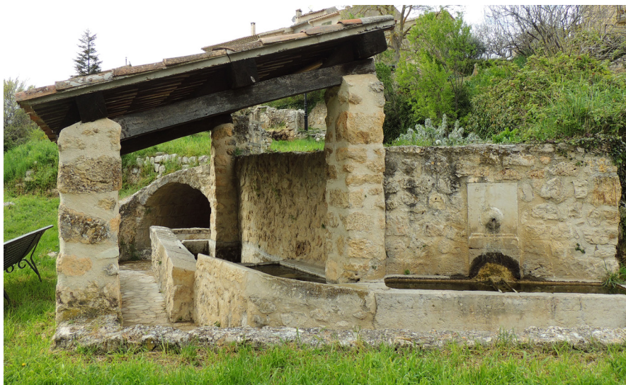
Passage du chemin de l'eau au coeur du village
