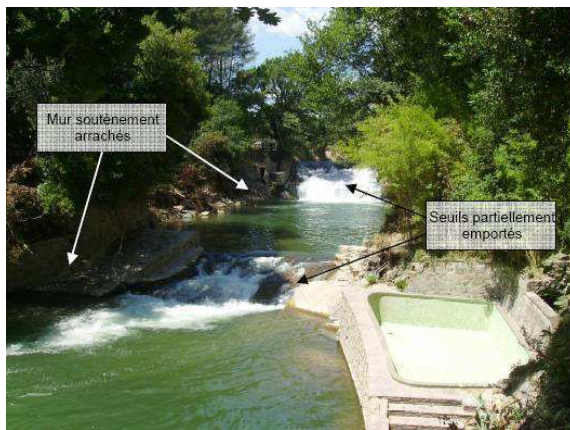
Photos 131 : Le Muy – Moulin de Serres – Vue post crue – source EGIS EAU
