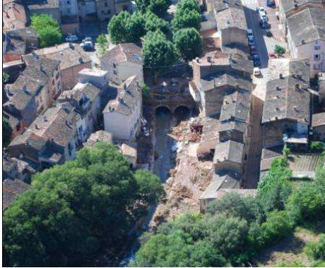
Photos 44 : Le Réal dans le centre ville des Arcs – Détail du passage souterrain – Vue amont post crue
