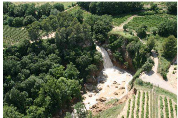
Photos 124 : Saut du Capellan - Vue post crue
