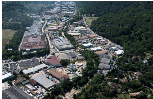
Photos 85 : Retour des eaux à la Nartuby - Voie Pompidou : Salamandrier -Post Crue
