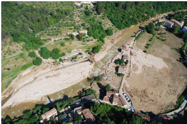
Photos 68 : La Nartuby à Rebouillon – Post Crue
