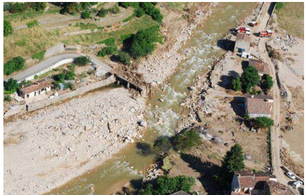
Photos 69 : La Nartuby à Rebouillon – Post Crue
