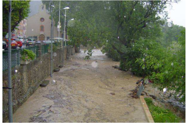
Photos 112 : Trans en Provence centre – Post Crue
