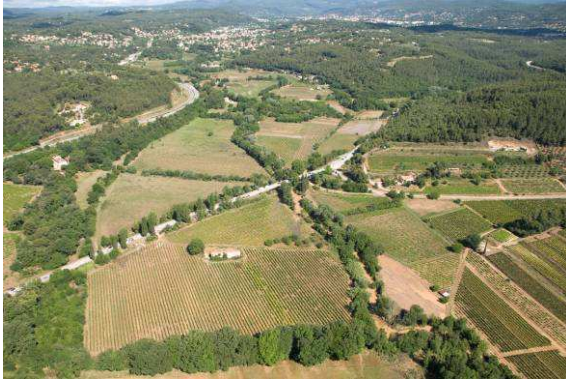
Photos 117 : La Nartuby au niveau de la RD54 – post crue
