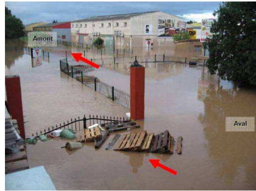
Photos 29 : Prise de vue de la Garonne dans la ZI de la Palud réalisée par l'entreprise K-Ro Céramique – 16/06/2010
