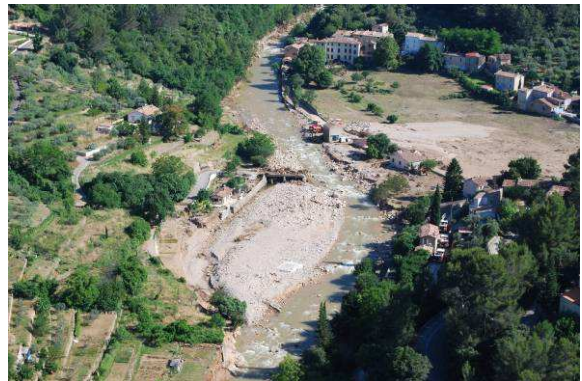
Photos 67 : La Nartuby à Rebouillon – Post Crue
