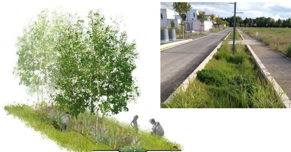
les noues champêtres : récupération et tamponnement des eaux pluviales le long des circulations
