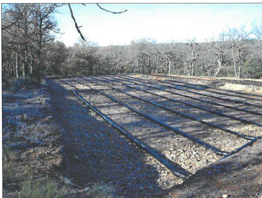
Massif Filtrant Végétalisé avant plantation - Photo extraite des dossiers techniques de l'ARPE (Novembre 2013)
