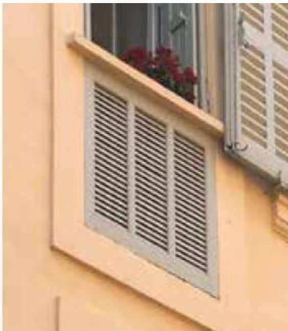
Grilles de ventilation intégrées dans les menuiseries
