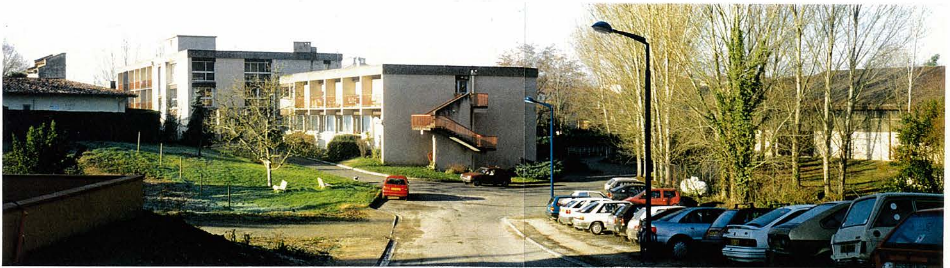
Vue de gauche à droite sur le jardin du centre socio-culturel, la maison de retraite le ruisseau de Segonde et le gymnase.
